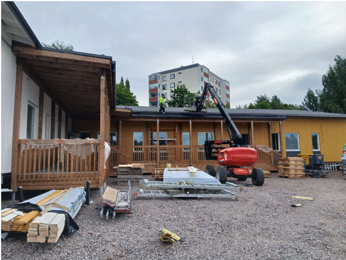
Bild: Gammelbacka biblioteks och ungdomslokal Kertsis tillfälliga lokaler i byggnadsskedet i augusti 2026
