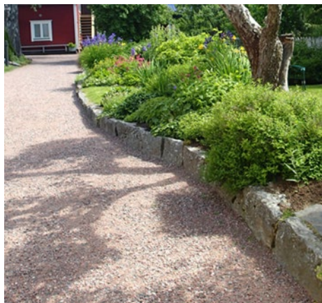
Bild 20 Körrutten och vändplatsen i bilden är belagda med röd makadam, som släpper igenom vatten, och omges av planteringar.
