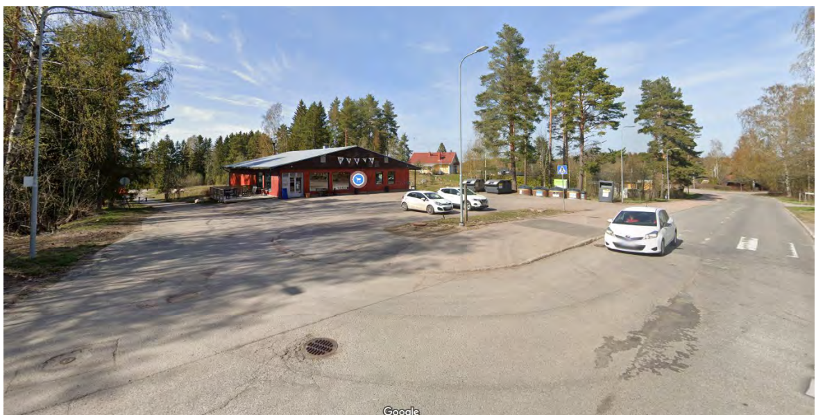
Kuva 2. Kaava-alue Rinnetien suunnasta kuvattuna. Etualalla näkyy pysäköintialue ja sen takana alueella sijaitseva liikerakennus. Rinnetie jatkuu kuvassa oikealle ja Rajamäentie vasemmalla (Kuvälähde: Google Street View)
