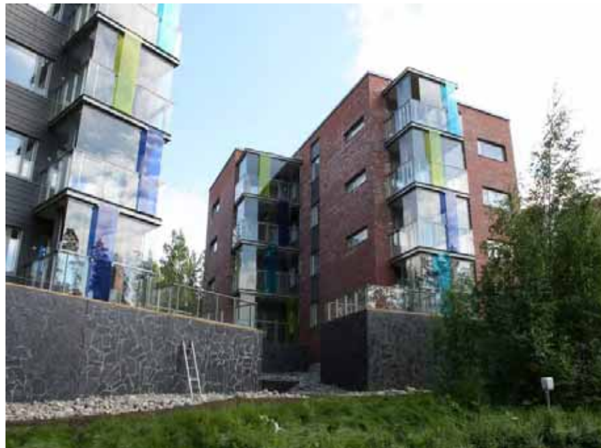
Kuva 5: Maaston tasoero ratkaistu kivimuurein.
