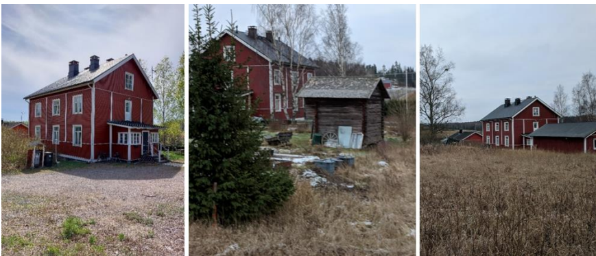
Kuva 14 Töyrytien rakennettua ympäristöä vanhan rautatien läheisyydessä
