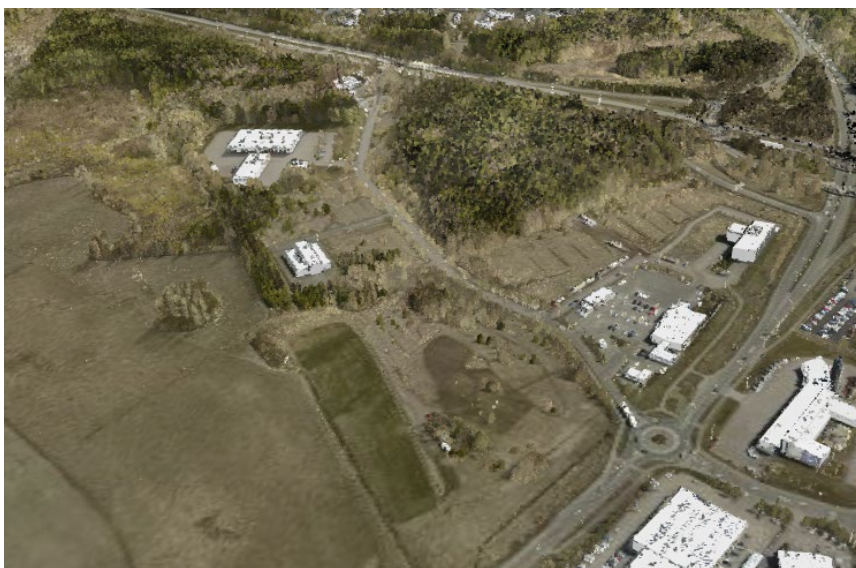
Bild 6 Utdrag ur planeringsområdet i en 3D mall, där man kan urskilja ett åkerområde till väster, Harabackavägen i mitten och motorvägsanslutningen till höger.
