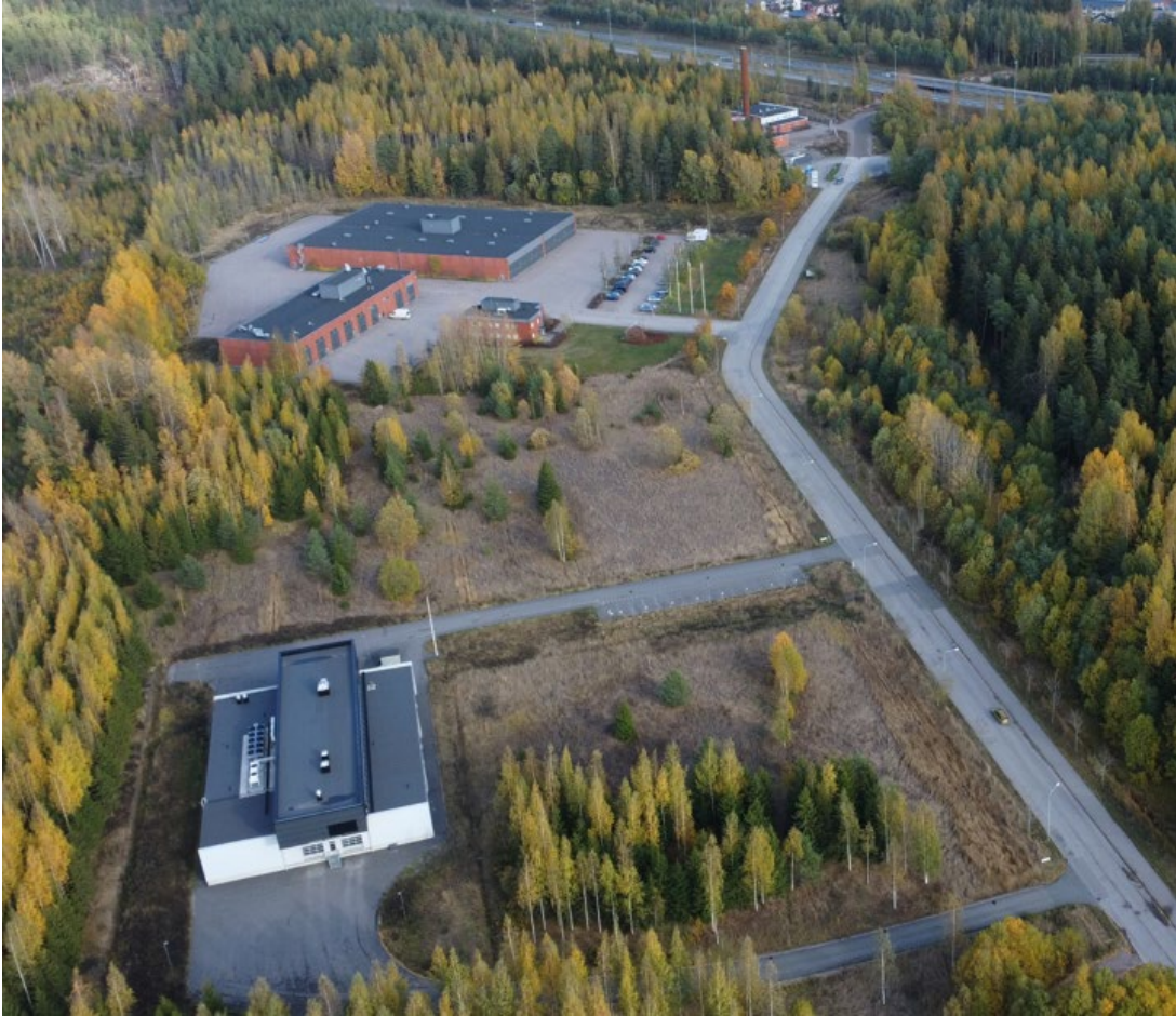
Kuva 5 Viistoilmakuvassa linja-autojen varikko taaempänä ja laitoskeittiö edessä.
