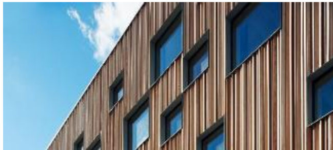
Bild 7. Den varierande djupa träfasaden skapar djupvariation och mjukar upp fasaden (Umeå School Of Architecture/Henning Larsen Architects).
