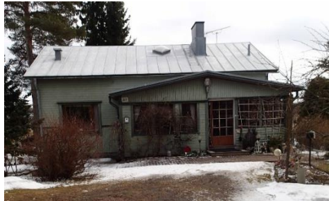
Kuva 8 Rintamamiestalo ei ole hirsirakenteinen. Ikkunat ja laudoitus on vaihdettu. Kellariin sijoitettu keskuslämmitys on tuonut julkisivulle uuden savupiipun.
