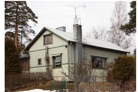
Kuva 7 1930-luvulla rakennettu hirsirunkoinen asuinrakennus on korotettu, kattomuoto on muutettu, ulkopuolelle on lisätty lämpöeristystä.
