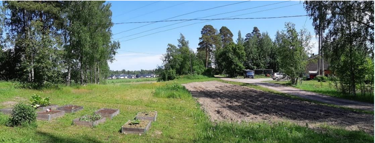
Kuva 16 Yksityisillä kiinteistöillä johtokäytävän aluetta käytetään kotitarveviljelyyn ja pysäköintiin.
