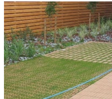
Bild 18. Stenbeläggning med gräs på parkeringsplats. Vattnet som rinner längs ytan leds till växterna vid kanten.
