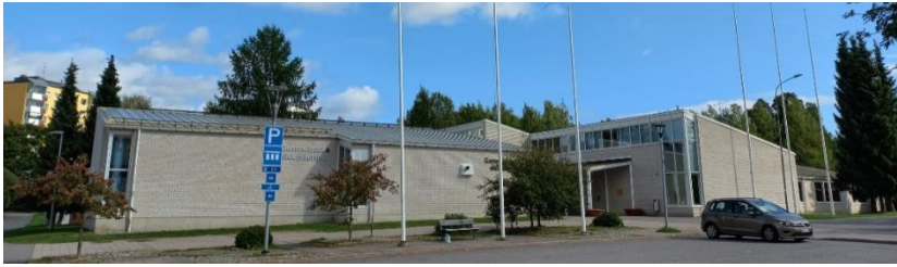
9. Allaktivitetshusets fasad sett från Centrumplatsen.
