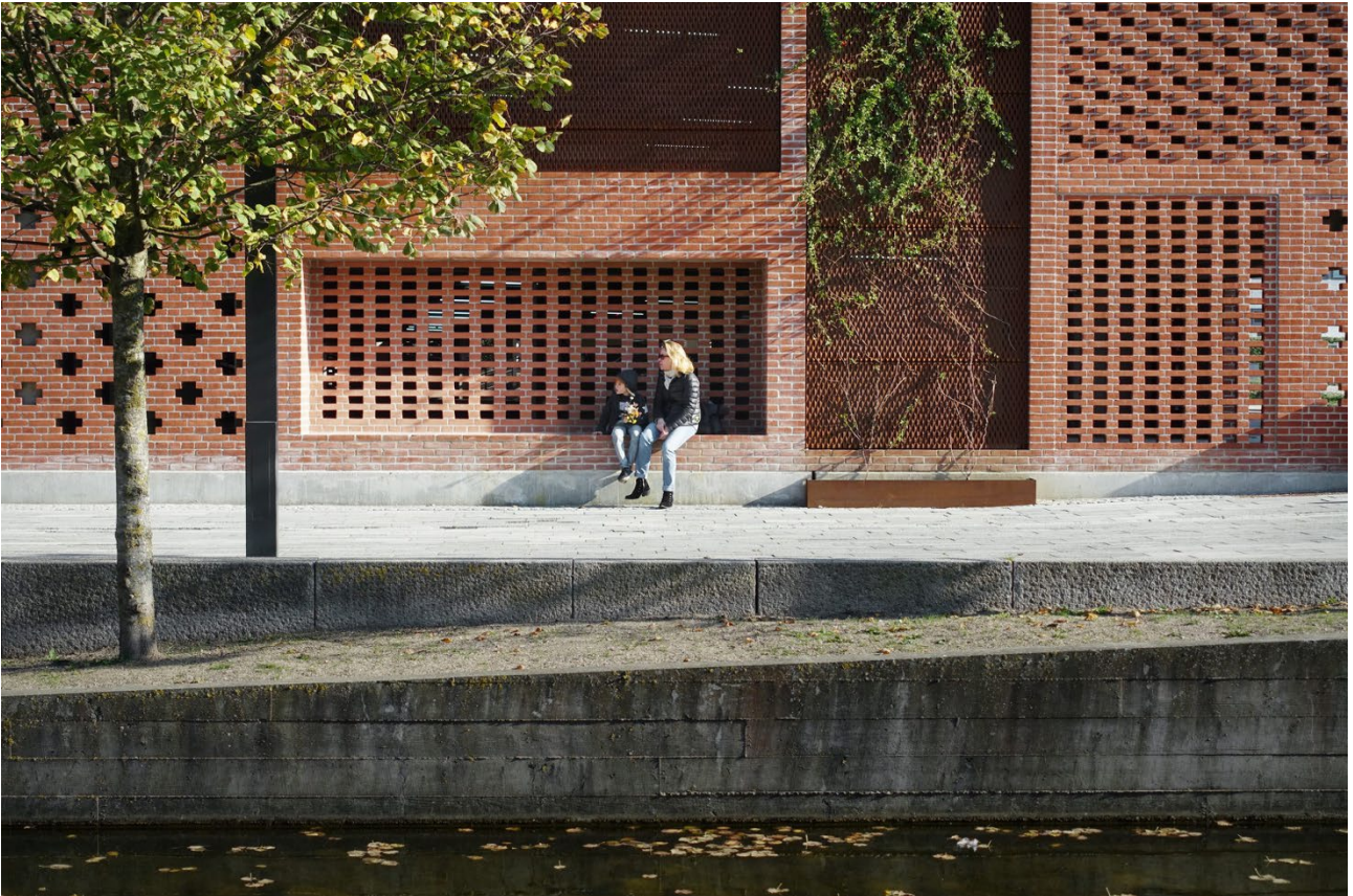
Bild24 Ett bra exempel på olika murningssätt och insprång på bottenplanets fasad. På bilden finns en bänk, en ranka och en reliefmurning som fällts in i fasaden (parkeringshuset Ejler Bille i Köpenhamn, Jaja Architects 2018)
