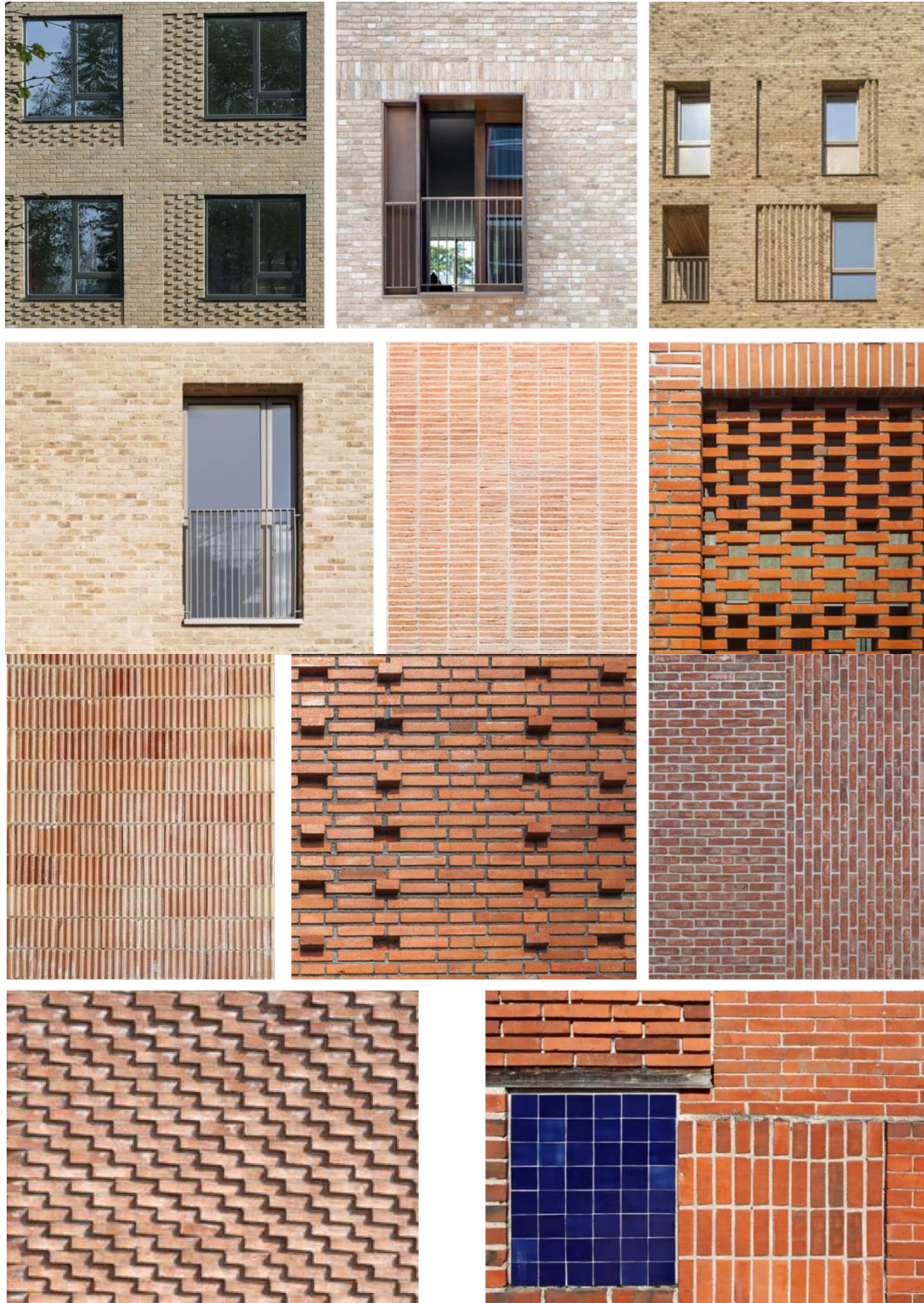
Bild 14 Materialpalett för byggnader med tegelbeklädnad: färgen på teglet kan vara nyanser av sand, nyans av rökt lera, grå, gul, ljus brun och rödsjiftande. Helt vitt, mörkbrunt eller svart tegel tillåts inte på bostadsvåningarnas fasader. Nyansen på rödtegel ska vara ljusare än på stenfoten.
