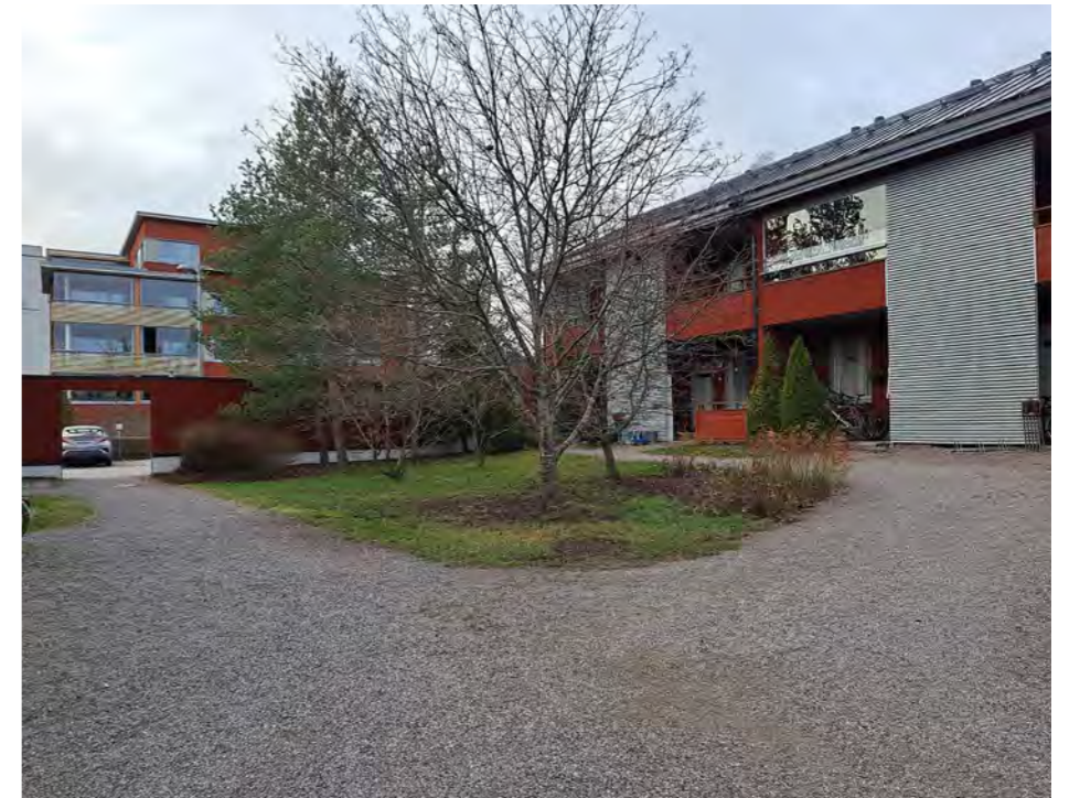
Kuva: Kulkureittien päämateriaali on kivituhka.
