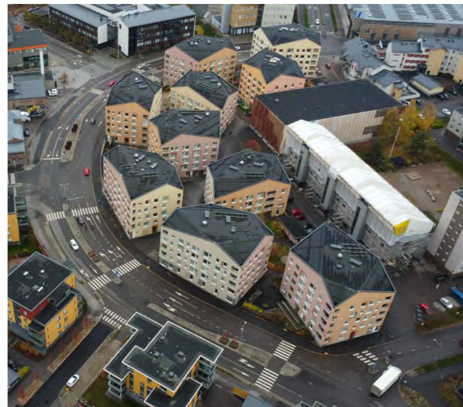
Viistoilmakuva. Rakennusten väliin jää pieniä pihatiloja. (Porvoon kaupunki)
