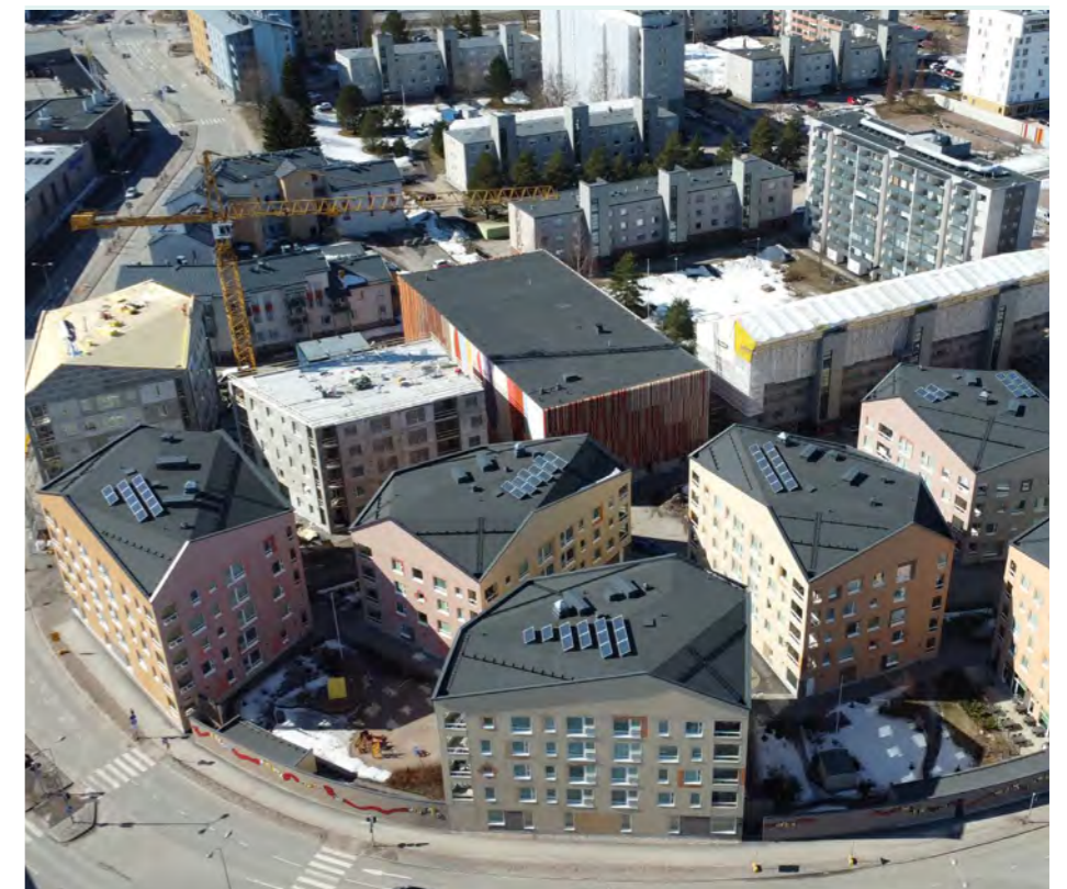
Viistoilmakuva. Rakennusten on sijoitettu todella tiiviisti. (Porvoon kaupunki)
