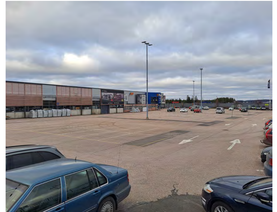
Kuva: Poistetut istutukset erottuvat vielä asfaltista.
