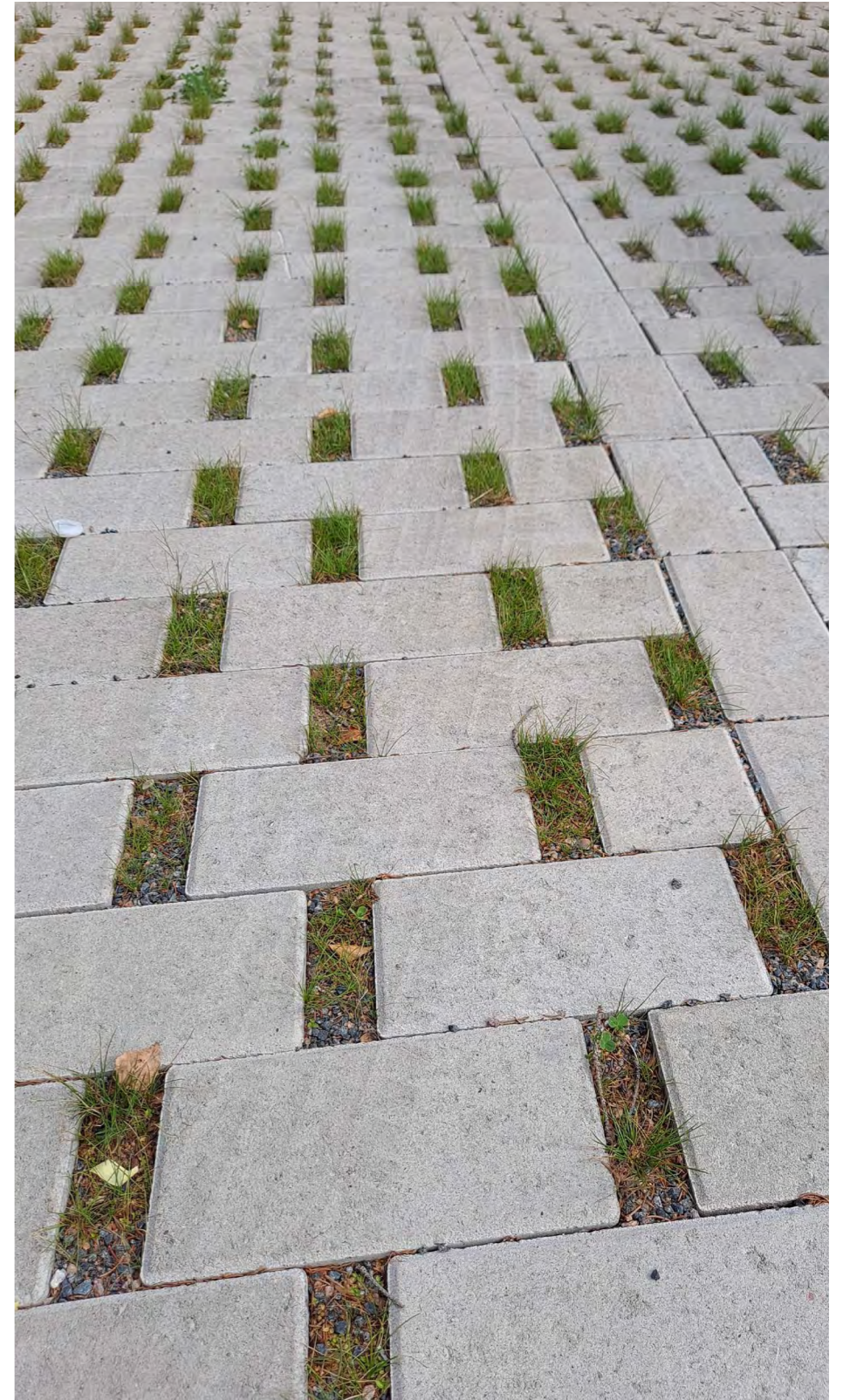
Kuva: Teollisuuden- ja logistiikan tonteilla voitaisiin käyttää enemmän puoliläpäiseviä pinnoitteita kuten nurmikiveystä.
