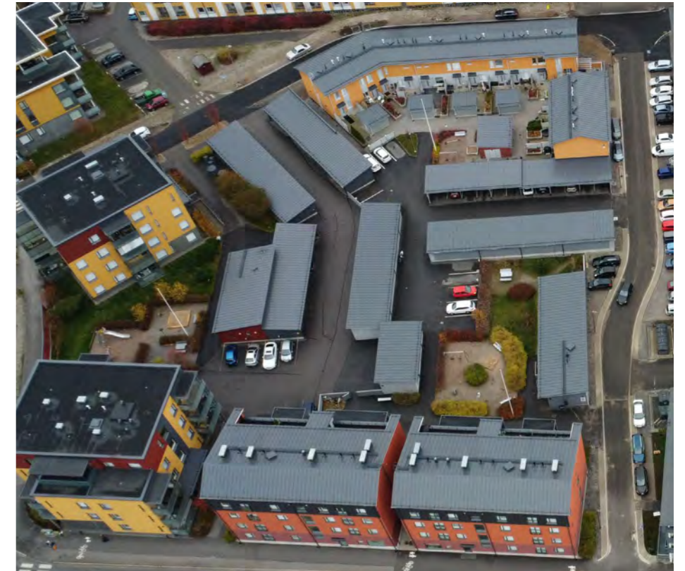
Viistoilmakuva. Autokatokset jakavat pihat pieniin osiin. (Porvoon kaupunki)
