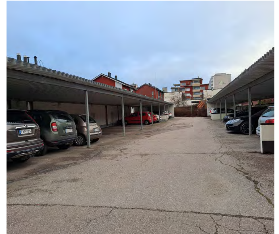
Kuva: Autokatosten välitila on asfaltoitu.
