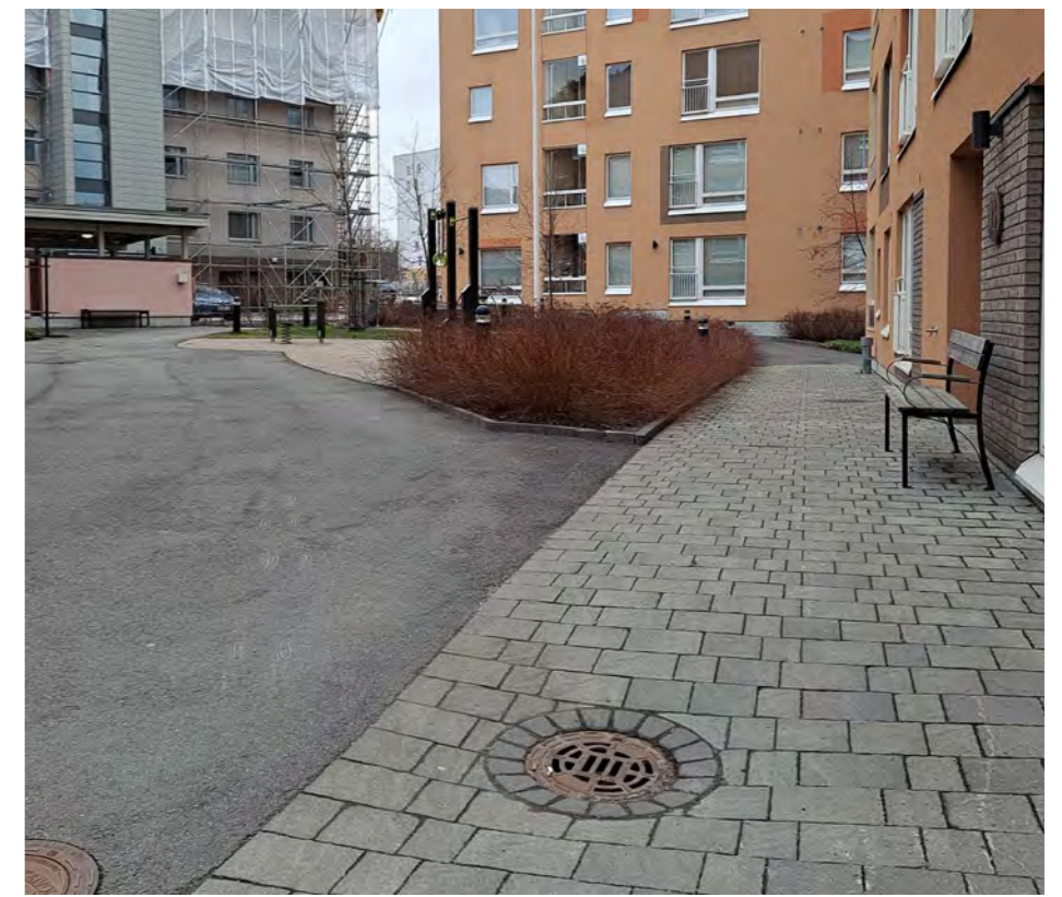
Kuva: Kaikki pihan päällysteet ovat joko asfalttia tai betonikiveystä.
