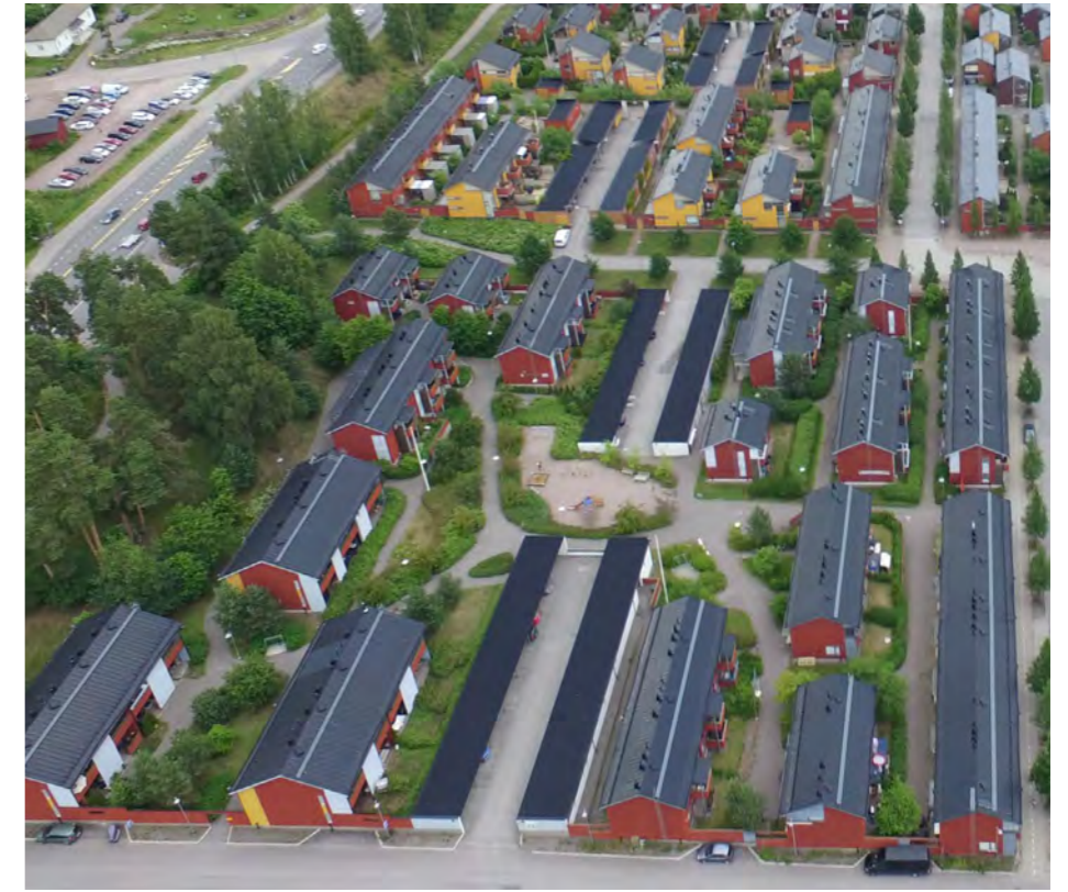
Viistoilmakuva. Kulkureitit ovat kivituhkaa ja pysäköintialueet asfalttia. (Porvoon kaupunki)
