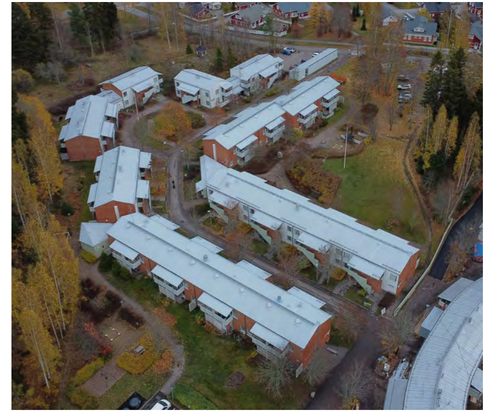
Viistoilmakuva. Rakennusten sijoittuminen kadun varteen on mahdollistanut isot yhteispihat niiden taakse. (Porvoon kaupunki)
