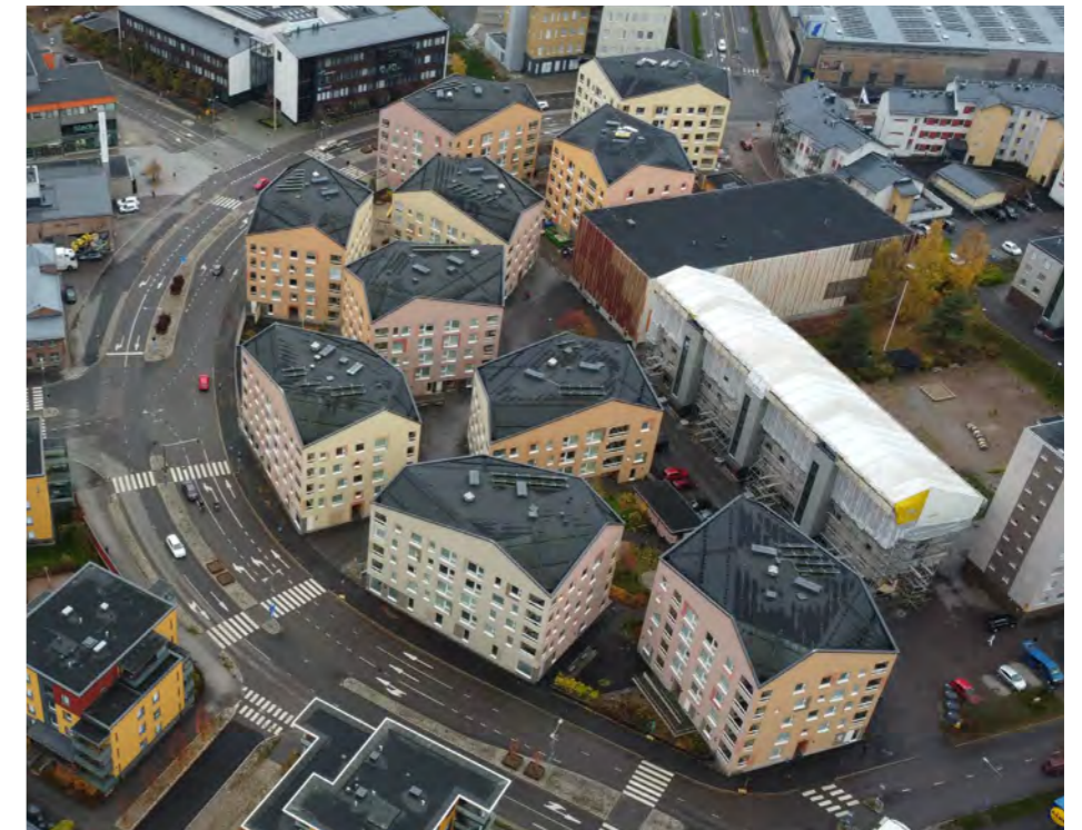
Sned flygfotografi. Byggnaderna har placerats mycket tätt, endast små gårdsutrymmen finns emellan dem. (Borgå stad)
